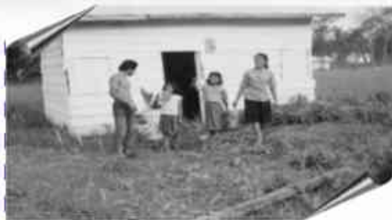
Tampak sebuah rumah transmigran yang baru saja ditempati di Proyek Singkut, Lampung
