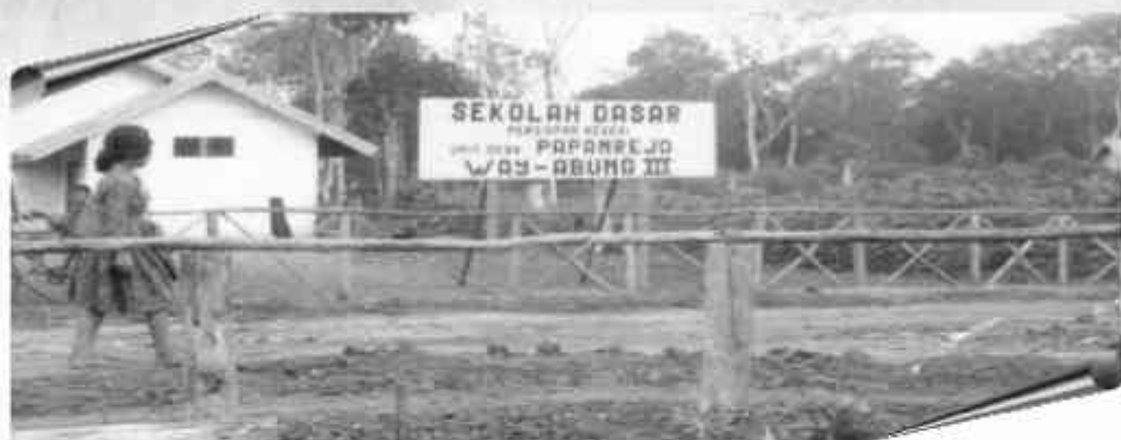
Tampak dari samping bangunan SD unit desa Papanrejo, Way Abung Lampung
